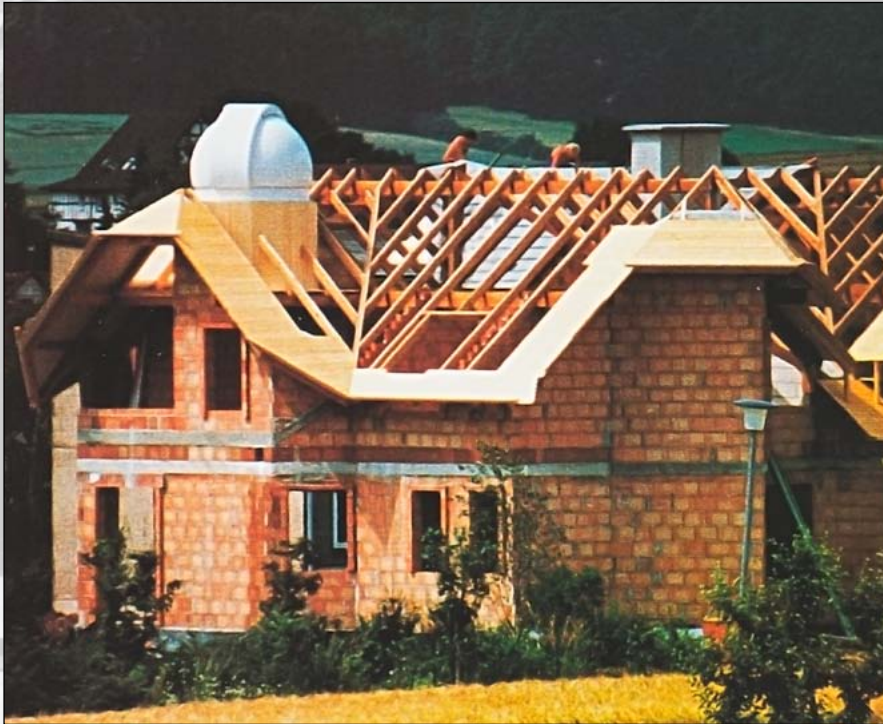
Die 2,1m Kuppel mit Flachdachadapter, montiert auf einem sechseckigen Holz-Unterbau
