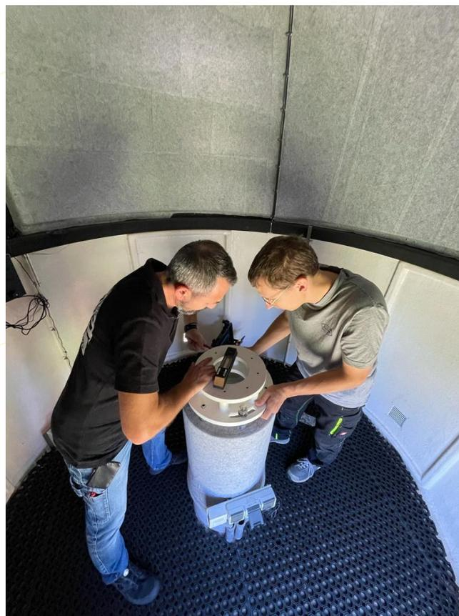
**Foto links:** Blick in die vorbereitete Kuppel, **Foto rechts:** Mitarbeiter der Fa. Baader bei den ersten Montagen und beim anschließenden Nivellieren der Aufnahme für die MICRON GS3000-Montierung und des Teleskops. Fotos © by Sternfreunde Sohland.
