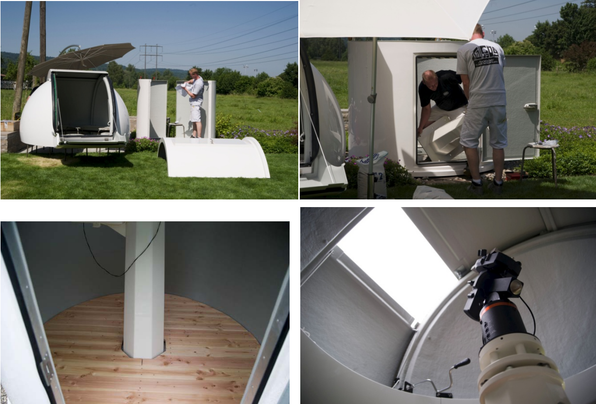
Abbildung 2. Links oben: Zusammensetzen des zylindrischen Unterbaus – Rechts oben: Einsetzen der Säule – Links unten: Fertiger Holzboden – Rechts unten: Säule mit CGE Montierung
