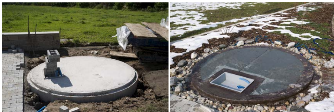
Abbildung 1. Links: Fertig ausgegossenes Betonfundament – Rechts: Elektroschacht im Fundament
