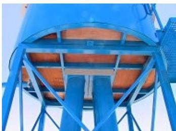
Die Instrumentenplattform steht - völlig getrennt vom Turm - auf vier massiven, konisch zulaufenden Stahlsäulen, die innen mit hochfrequenzverdichtetem Beton gefüllt sind.
