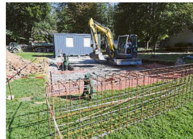
Derzeit wird das Fundament für die Kuppel vorbereitet, in dem das große Teleskop untergebracht wird.
