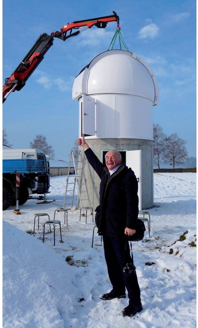
Heinz Reinhardt freut sich, dass die Kuppel nach langer Prozedur passgenau auf dem darunter liegenden Ring, der zuerst auf den Betonsockel aufgesetzt wurde, montiert werden konnte.
